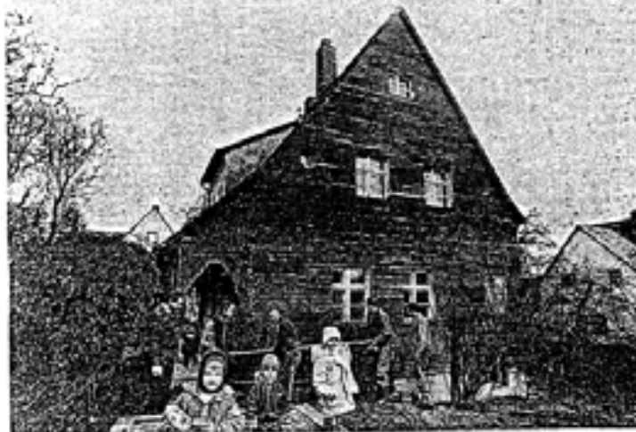
Der Abbau der Außenanlagen, der Sandkästen, Klettergerüste und Schaukeln, am Gebäude im Jägerweg bildete in den letzten Tagen den Abschluß des Umzuges in das neue Haus
